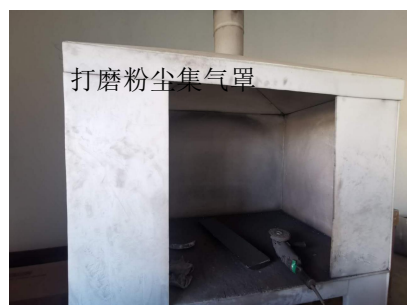
图 4-11 清洗车间 废气处理设施现场图
