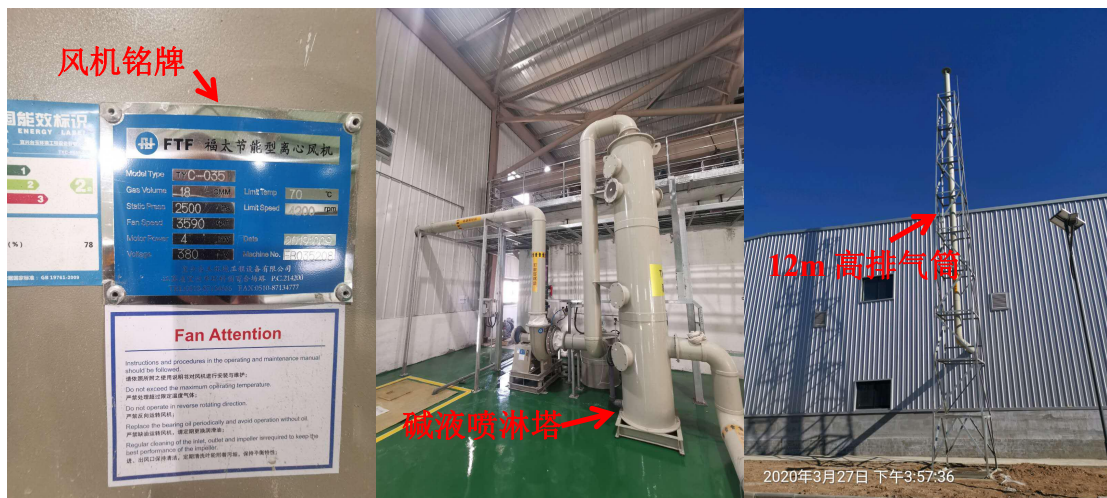
图 4-12 含酸废气处置装置现场图
