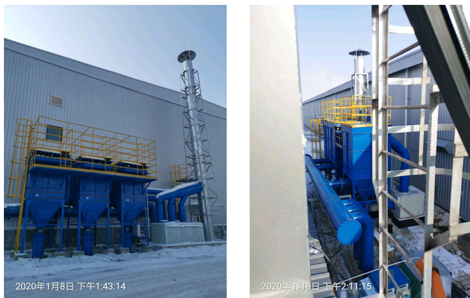
图 4-7 单晶一车间粉尘处理设施现场图
